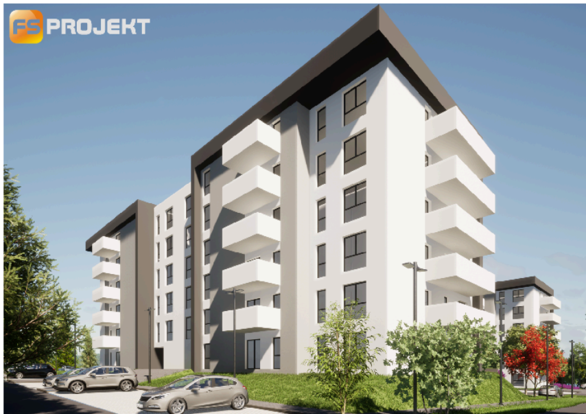
BUDYNEK NR 2 WIDOK OD STRONY WEJŚCIA
