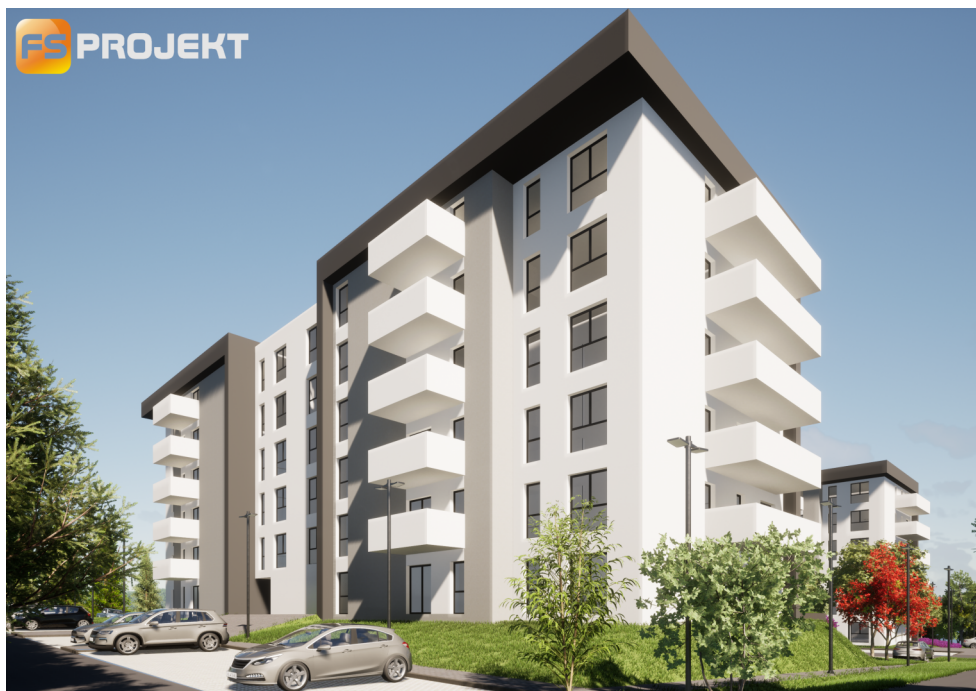
BUDYNEK NR 3 WIDOK OD STRONY WEJŚCIA
